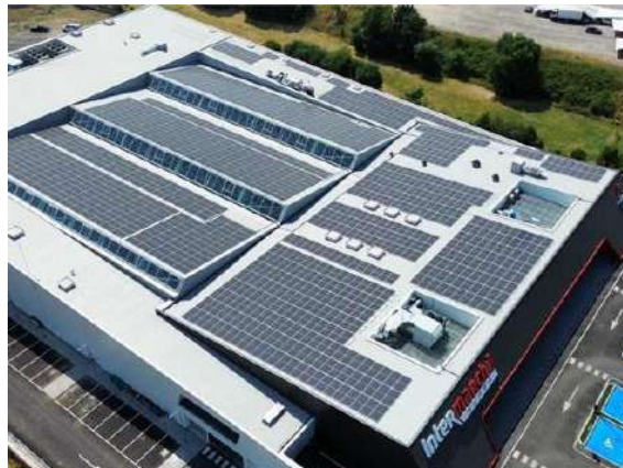
Finalização Intermarché Torres Novas Portugal
